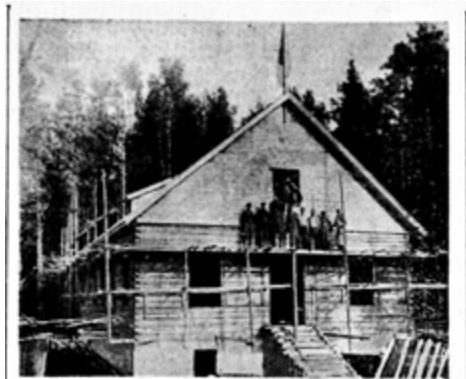
Sä-talo Satakuntaan Turun Merisuojeluskunnan Kaksikerran—Hirvensalon divisioonan suojeluskuntatalon rakennustyöt Satakunnan Nakkilassa ovat jo ehtineet niin pitkälle, että lauantaina olivat harjannostajaiset. — Suojeluskuntatalo tehdään urakalla, mutta kutsu tehdään talkoovoimin. Satakunnan oliikin divisioonan miehit lauantaina paikalla alkaneen työn lisäksi. Lotat olivat talkooväestölle lauantain aamuna päivälliset lähellä olevalla Satakunnan kansakoululla ja siinäpäivällä tarjottiin harjakaiskahvit rakennusmiehille, talkooväestölle ja rakennuslautakunnan jäsenille. Talo valmistuu käyttökuntoon elokuun loppupuolella.
