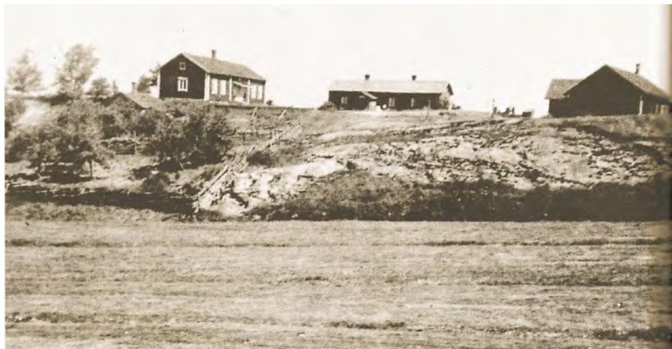
Ylitalon rakennukset sijaitsivat samaisella kyläkumpareella kuin Alitalo. Ylitalon pihapiirissä oli kaksi asuinrakennusta. Brinkhallin kartanon työväen käytössä olleet rakennukset purettiin 1950-luvun lopulla. Jäljelle jäi ainoastaan pieni kivikellari, joka häähöttää vanhassa kuvassa rinteessä pääarakennuksen päädyn alapuolella. Kaksikertaa kiertämässä, s. 62.
