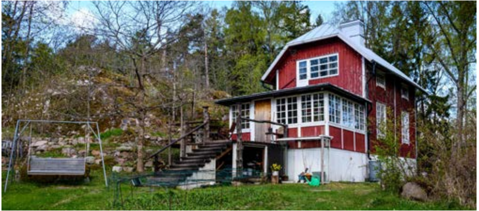
Ingmanien 1900-luvun alussa rakennuttama Bråvallen toinen huvila, joka palveli myöhemmin kaupungin kesäsiirtolan keittiö- ja henkilökunnan asuintalona. LK 2019.
