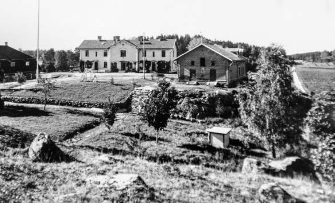
Poikakodin pihapiiriä pohjoisesta n. 1930. Virkatalolle 1870-luvulla pystytetyt rakennukset uudistettiin poikakodin tarpeisiin. Vasemmalla navetta, takana keskellä entinen väentupa, joka korotettiin poikakodin majoitusrakennukseksi ja oikealla makasiini, joka palveli jatkossa mm. verstastiloina. TKA, LK.
