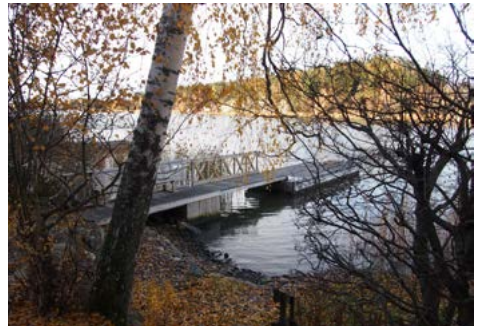
Pienet hyökyaallot eivät keinuttele betoniponttonin päällä kelluvaa jyvettä laituria.
