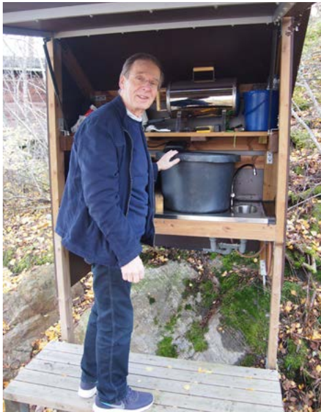
Markku Kalliomäen insinööritaidon näyte: kalanperkuulaitoksen etuseinä nousee katokseksi työtilan päälle.
