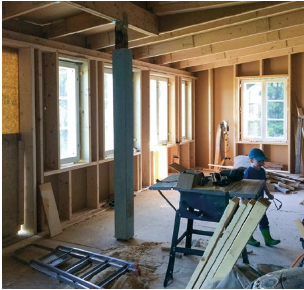
Aarni-poika osallistui innolla lasive- rannan rakentamiseen.
