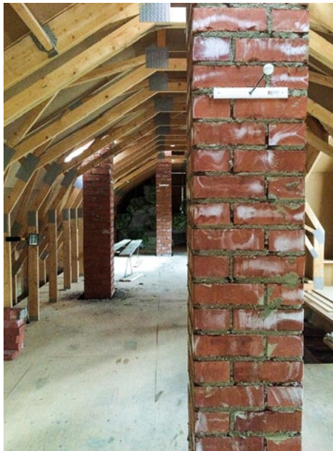
Yläkerta ja kattorakenteet: tänne saatiin korotuksen jälkeen kolme asuinhuonetta
