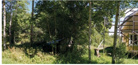
Rakennustelineiden alla näkyy talon katkos: yläosa sahattiin irti ja väliin kangettiin 80 sentin korotus.
